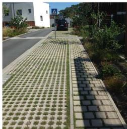
Stationnements en dalles engazonnées isolés des logements par une large bande plantée
